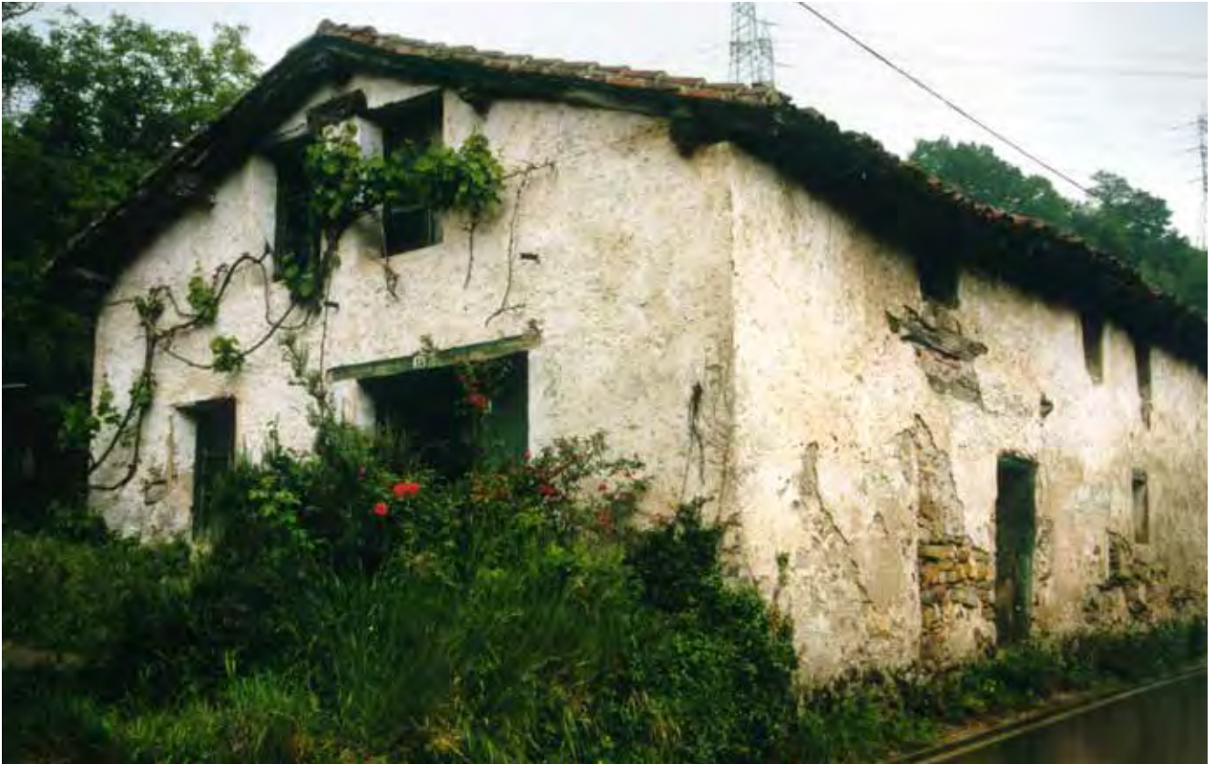
“Oficinas” de Oyaneder. Edificación en Osifiaga bailara de donde salieron las primeras anclas y anclotes de la Real Fábrica de Anclas (Foto: L. Lerchundi).
