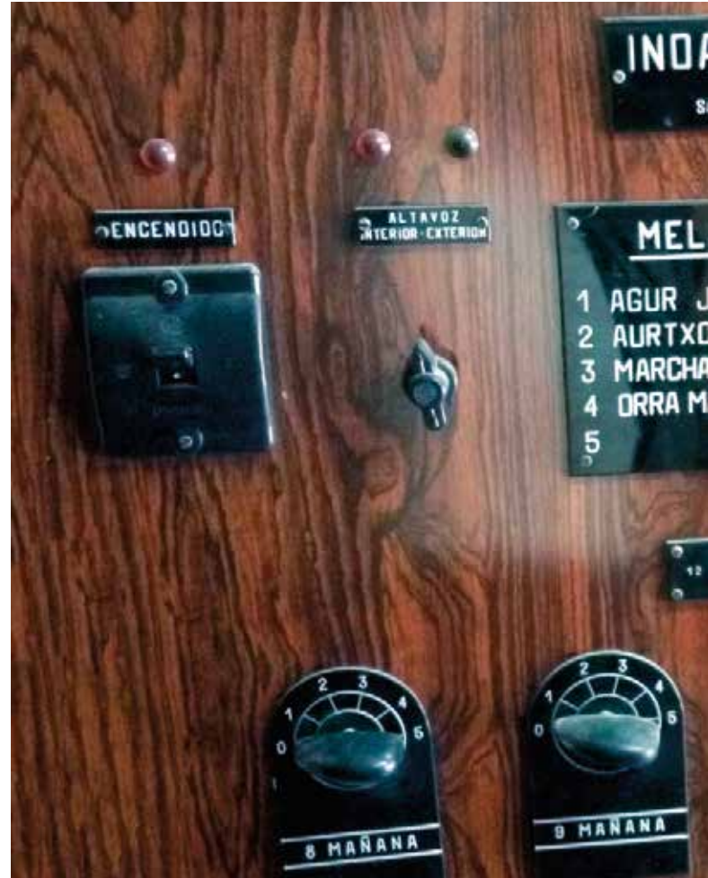
Mecanismo de control de las melodías que sonaban en el reloj - carillón de Plaza Berria.
