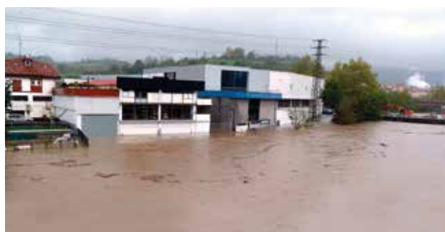
Zonas industriales de Hernani implantadas en las riberas del río Urumea. Inundación del 6 de noviembre de 2011.
