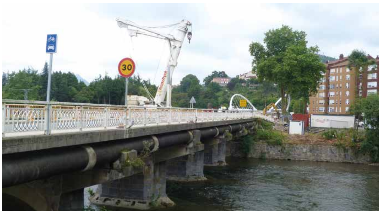
El actual puente de Karabel será demolido al finalizar la construcción del nuevo puente.
