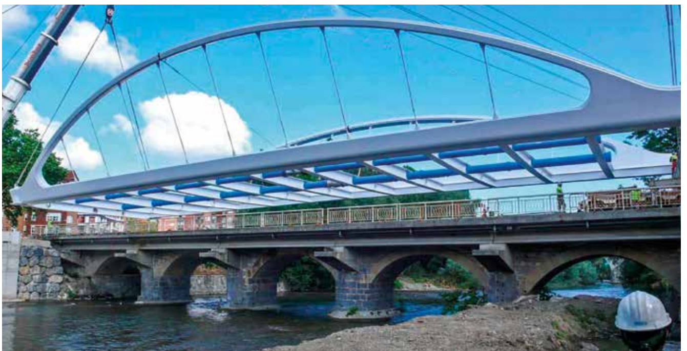
Secuencia del montaje del nuevo puente de Karabel (URA - Agencia Vasca del Agua).
