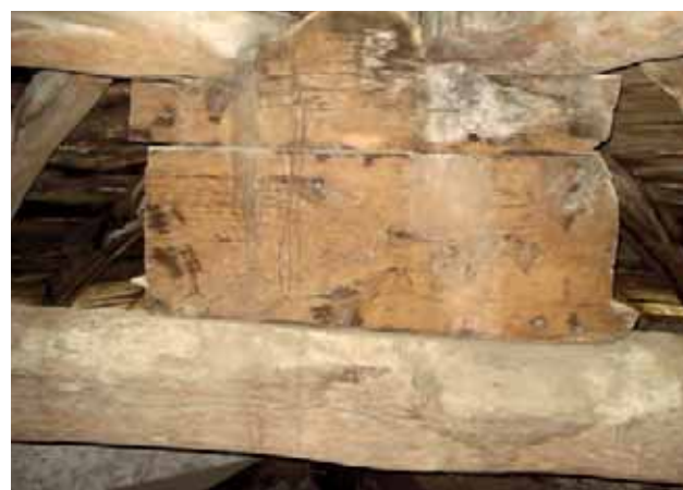
Detalles del sistema de ensamblaje. Fotografías: Fco. Javier Yarza.
