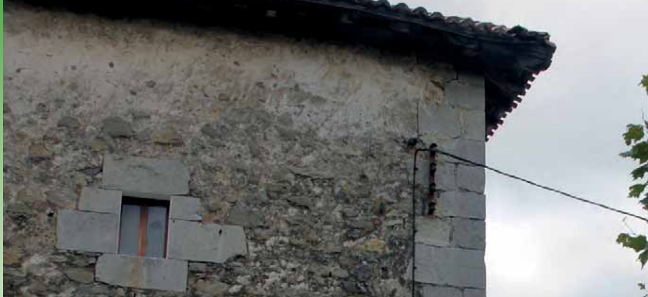
Detalle de la fachada, en la que se puede apreciar la cantería de sillería empleada en esquinales y recerco de vanos.
