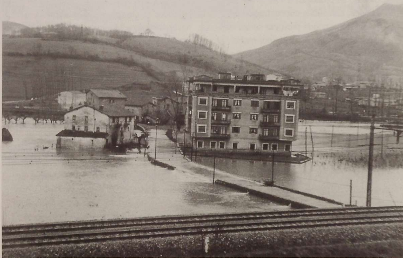
Imagen de Karabel tras el desbordamiento del río Urumea, tras las inundaciones de diciembre de 1960 (Fotografía: Udal Artxiboa)
