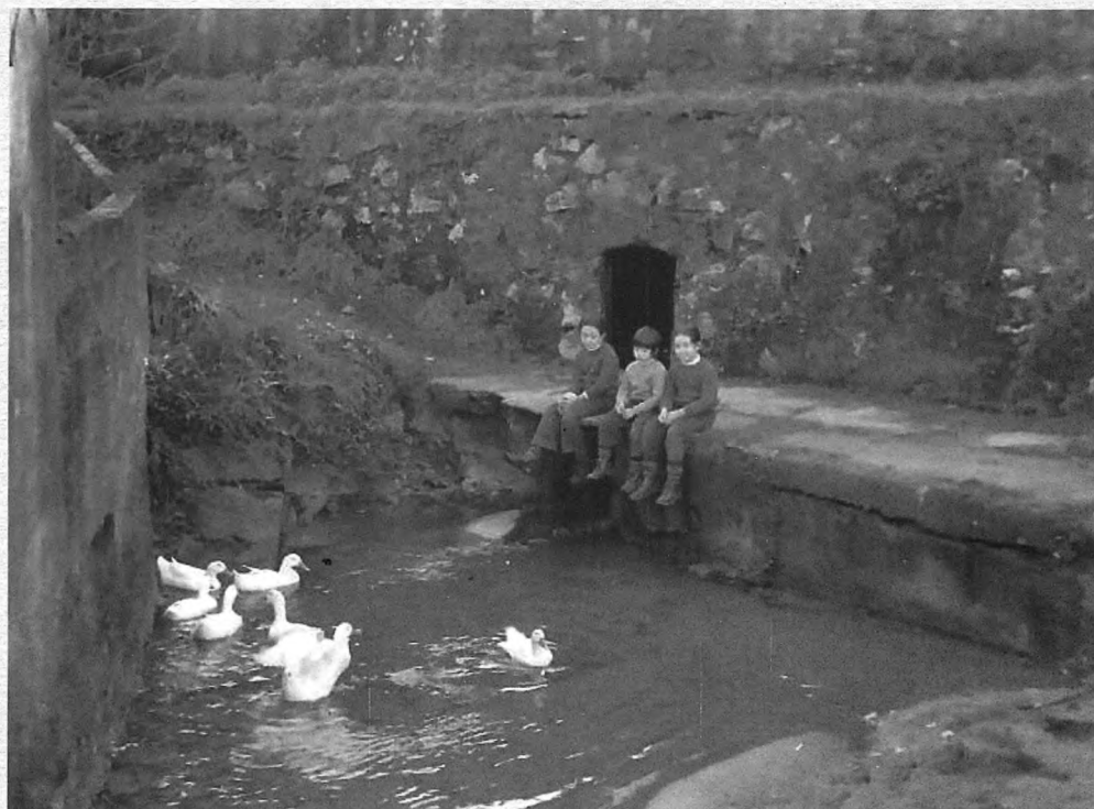
Nacadero de la regata Iturregi, situado debajo de la fábrica Santiago Carrero
