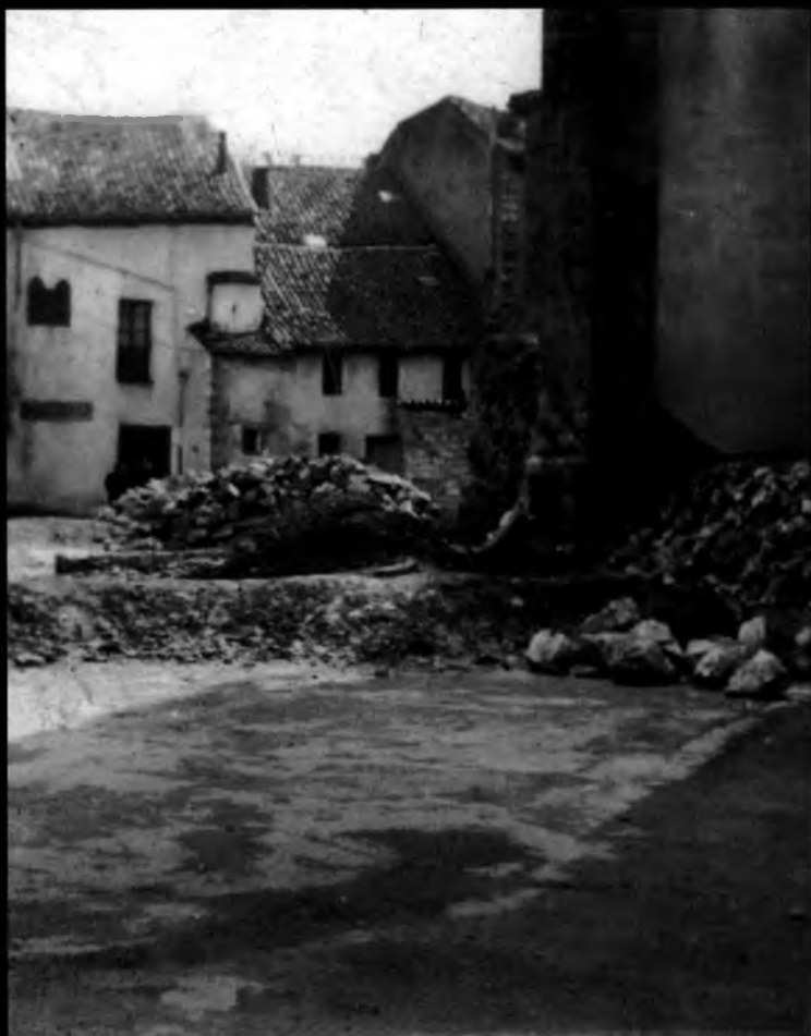
1952. Frontoia eraikitzeko lanak. Obras de construcción del frontón.
