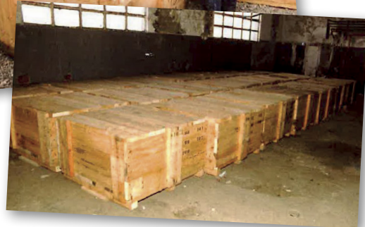
Desmontaje y almacenaje de las piedras de la fachada (1987).
