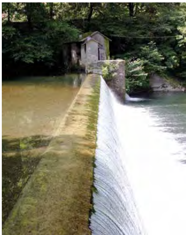
Pikoaga - Mandarrietako Zentral Hidroelektrikoaren presa.
