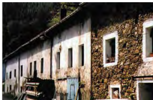
Fig. 3. Vistas de las viviendas desde el lado este.
