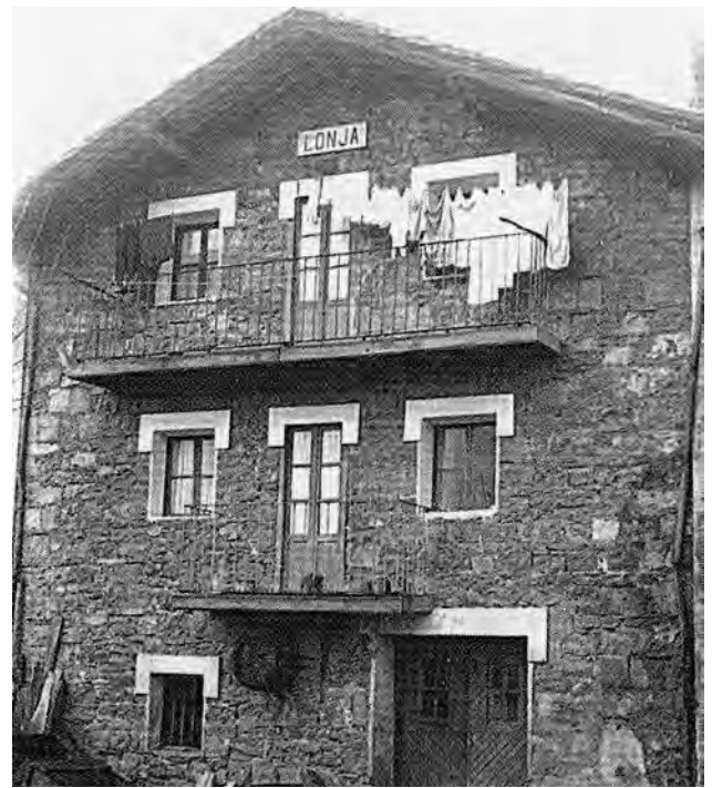
El edificio del puerto hernaniarra dedicado a lonja sigue hoy manteniendo su nombre.
