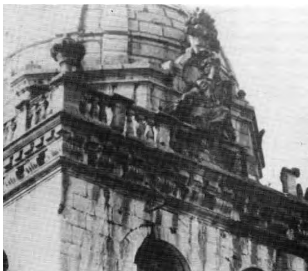
Cúpula de la torre y balaustrada (antes de restaurar).
