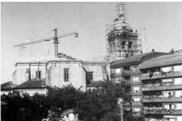
El exterior de la Iglesia durante las obras de restauración (Otoño 1.992).
