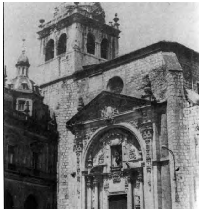
Fachada principal de la Iglesia y torre (antes de la restauración).
