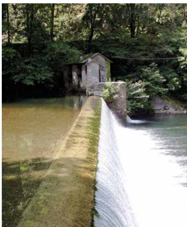
Pikoaga - Mandarrietako Zentral Hidroelektrikoaren presa.
