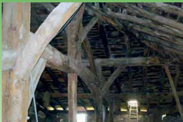
Detalles de la estructura interior de madera. Fotografía: Fco. Javier Yarza.
