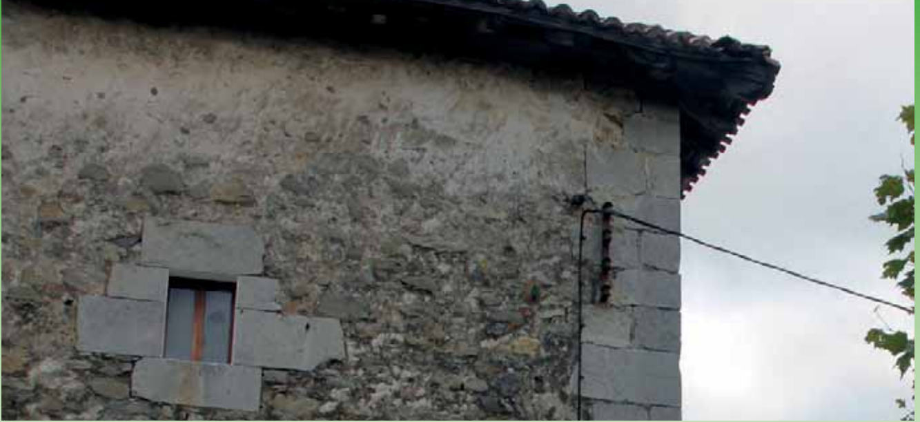
Detalle de la fachada, en la que se puede apreciar la cantería de sillería empleada en esquinales y recerco de vanos. Fotografía: Jesús Mari Gómez "Txuso".
