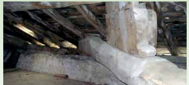
Detalle bajo cubierta. Fotografía: Fco. Javier Yarza.
