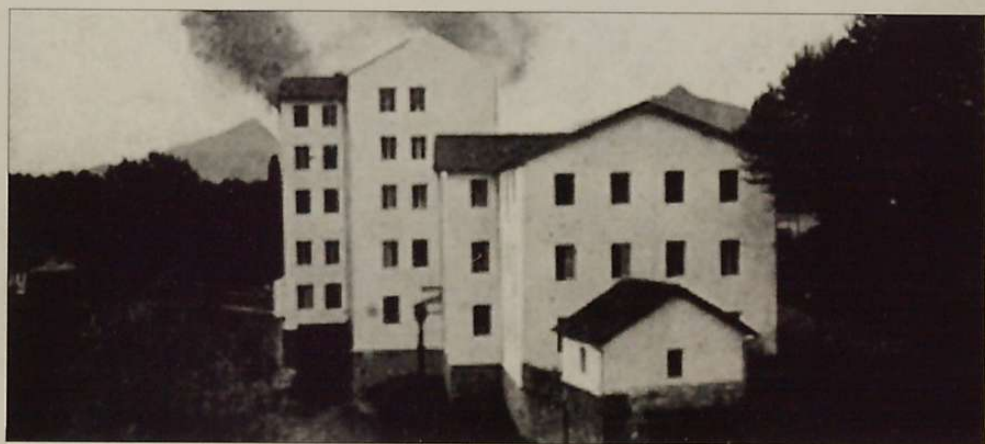
Vista en conjunto de la fábrica.
