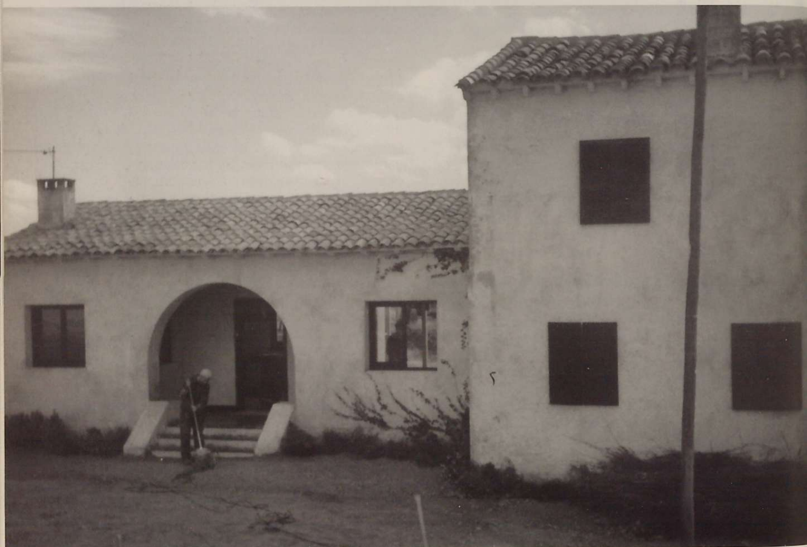
Dos momentos en la construcción del decorado de la "casa de Angela", trabajo realizado en Cariñena para la película "Tierra", de Julio Medem.
