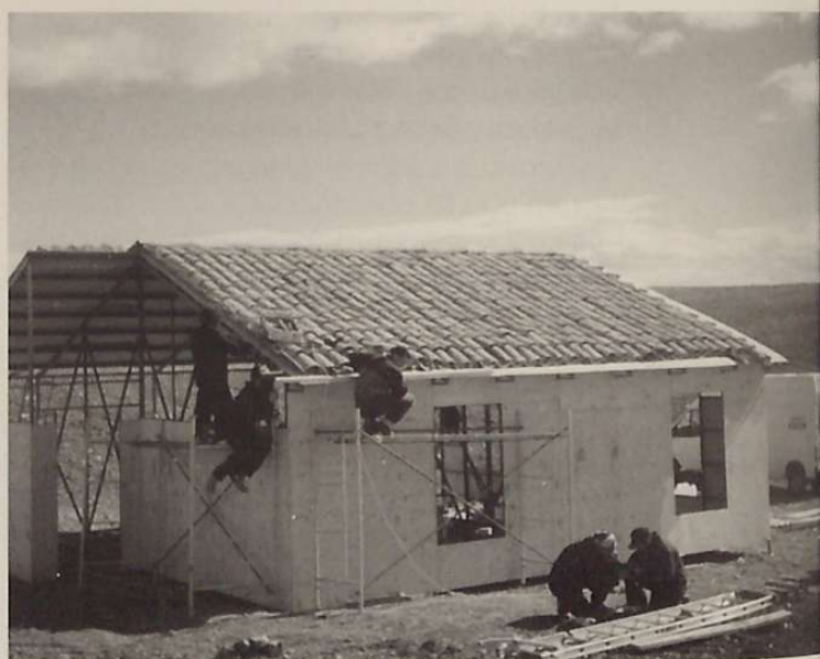
Satur y sus colaboradores, durante trabajos de construcción de un decorado.
