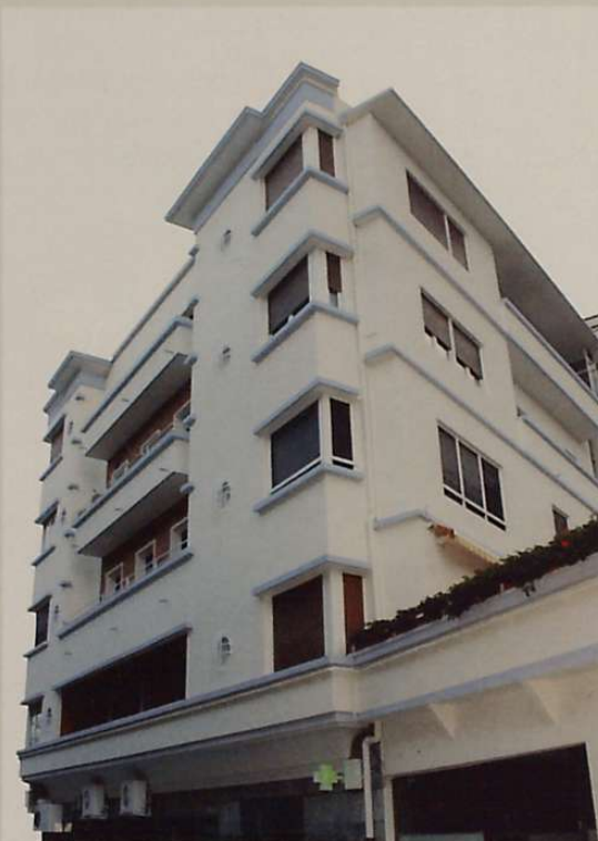
Kardaberaz kalea, 48. Mokoroo arkitektoak eginiko etxea, hormigoizko lehena.
